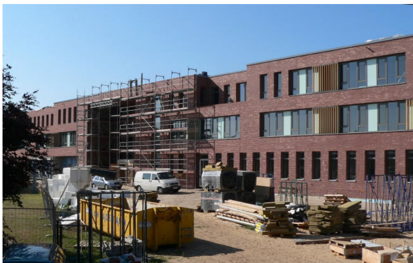
Aktuelle Ansicht des Rohbaus
